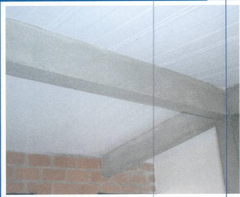
Este sistema está compuesto por bandejas estructurales de acero galvanizado con un sistema de solape totalmente hermético, las cuales se rellenan con láminas de Poliéstireno Expandido de clase autoextinguible de marca ISOTEX<sup>®</sup> de densidad variable.
