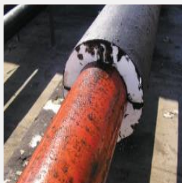
Tuberías aisladas térmicamente con conchas en Poliestireno Expandido (EPS)
