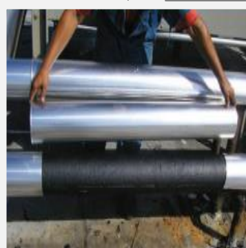
Tuberías aisladas térmicamente con conchas en Poliestireno Expandido (EPS)
